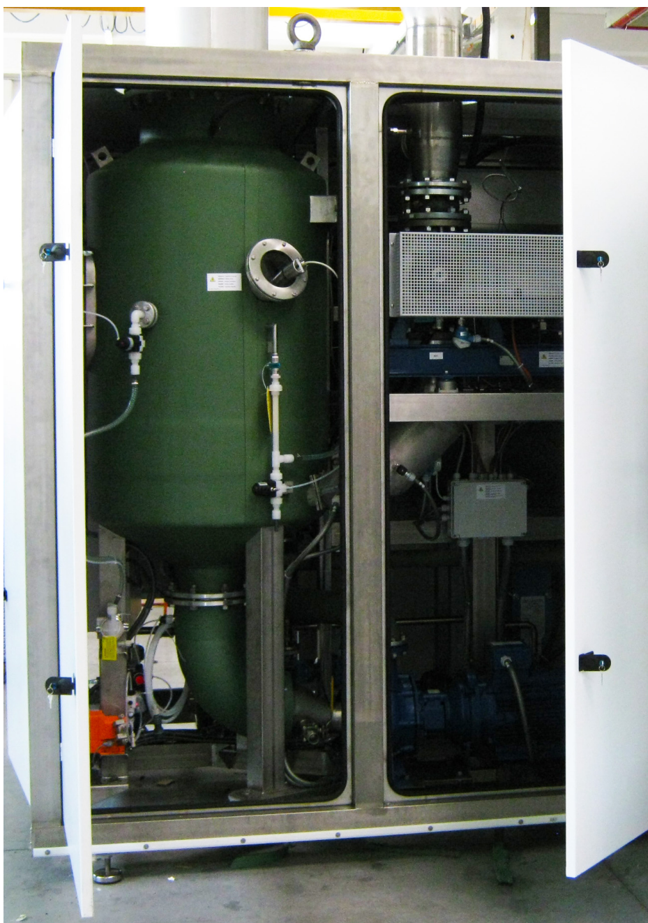
Foto 2: De binnenzijde van een verdampner, waarin het afvalwater wordt gezuiverd tot herbruikbaar proceswater.
