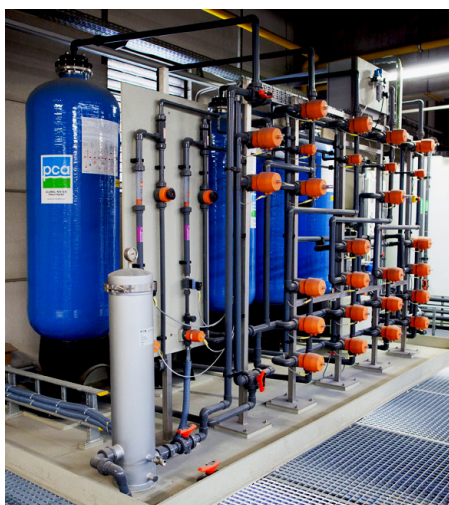
Foto 1: Via een gesloten kringloop wordt demiwater continue hergebruikt en is er dus geen verlies.
